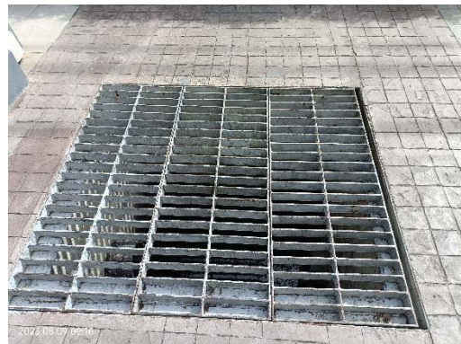
บ่อพักน้ำสุดท้ายก่อนปล่อยออกสู่ภายนอกโครงการ
