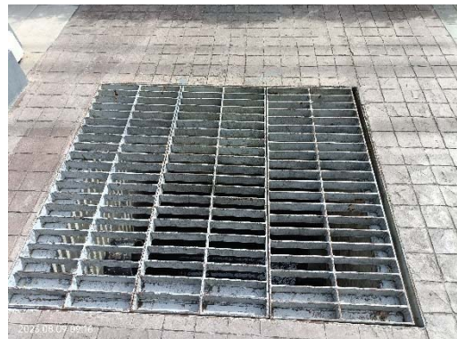
ตะแกรงดักขยะ ในบ่อพักน้ำสุดท้าย ก่อนปล่อยออกสู่ภายนอกโครงการ
