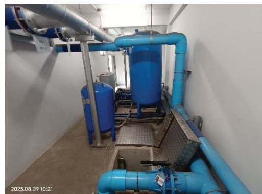
ปั๊มสูบน้ำไปยังอาคาร A-E
